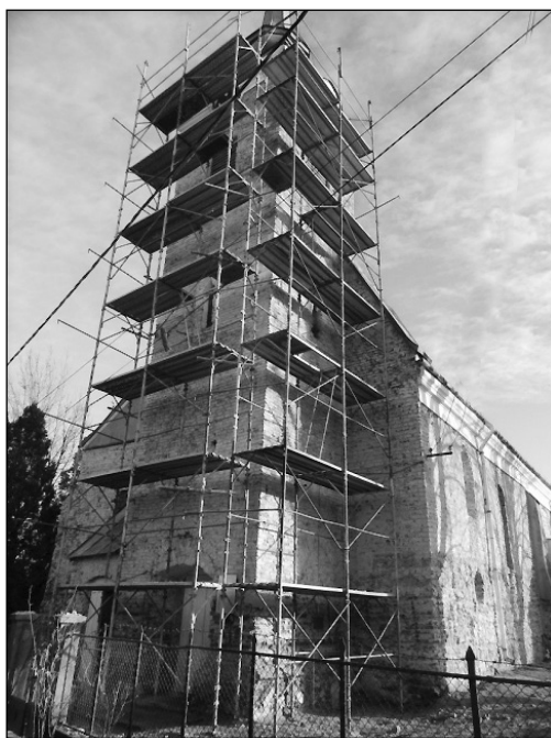
A felállványozott torony
